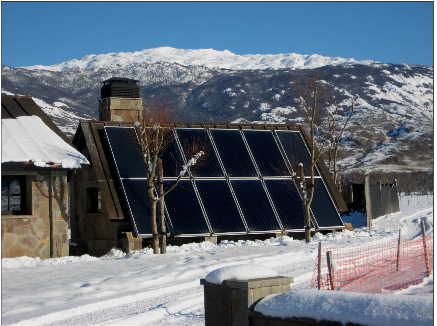
Aporte de Agua Caliente Solar
