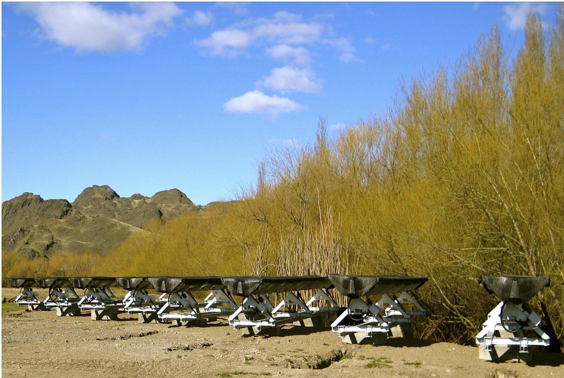
Colectores Solares Parabólicos
