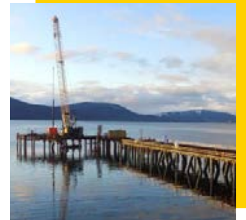
Puerto Multipropósito Puerto Williams. Región de Magallanes
