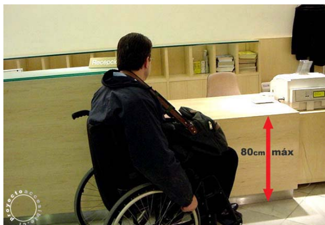
Foto 22: Altura máx. de mesón de recepción.
