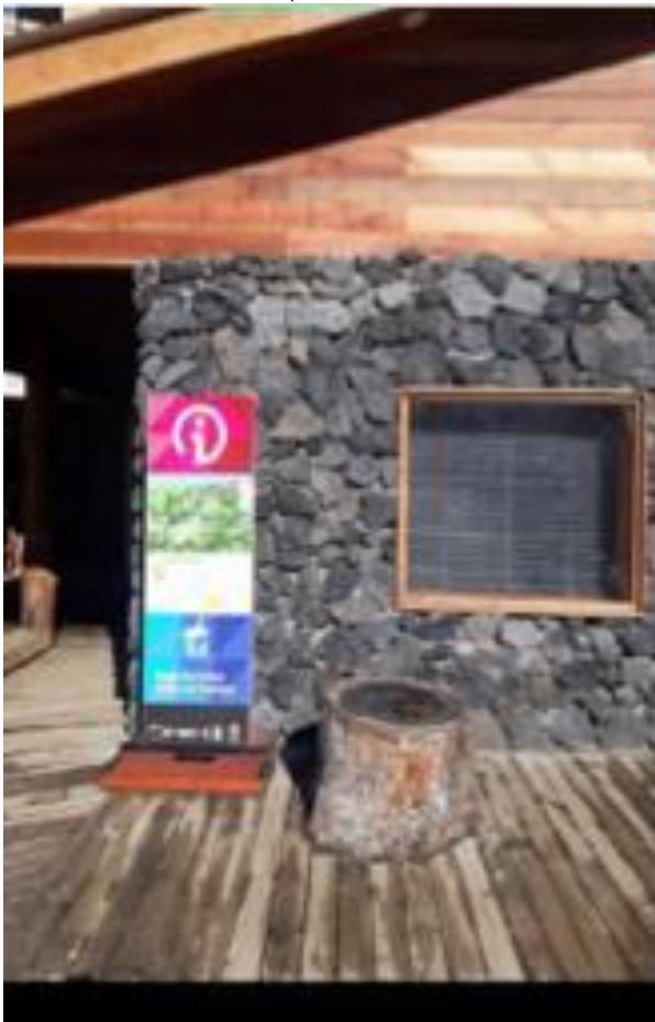
Fotografía: OIT Valle las Trancas, implementada.
